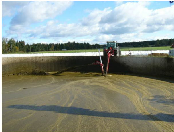
Figure 8 – Des eaux usées peuvent être entreposées avec les déjections animales à l'intérieur d'une structure d'entreposage étanche (Savard, 2006)
