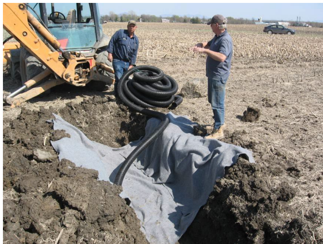
Figure 29 – Construction d'un puits d'infiltration (Guillou, 2008)
