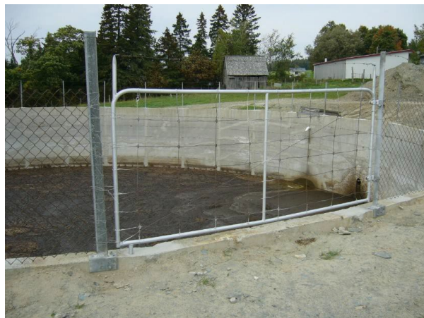
Figure 9 – Entreposage de déjections animales liquides dans une structure d'entreposage étanche (Savard, 2006)
